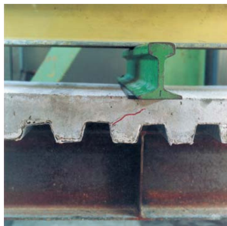
Fig. 34 Muestra t2 después del agotamiento de la viga de acero: detalle en medianería. 34
