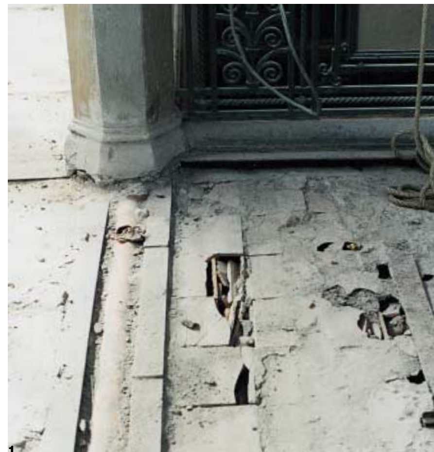
1 - 2. Stato di fatto e fase di smantellamento del sottofondo
