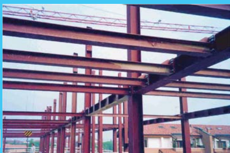
Se empieza montando los pilares y las vigas de acero.
