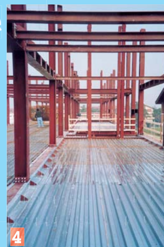
Vista de un edificio de varios pisos: en el piso inferior ya se han colocado las planchas onduladas y los conectores. Se está colocando la red electrosoldada.
