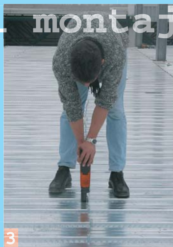
Después del emplazamiento de las planchas onduladas se puede proceder a la hincadura de los conectores. Con una única operación se bloquean las planchas y se realiza la conexión. No se precisa mano de obra especializada y las herramientas incluso se pueden alquilar.
