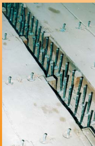
Conector en contacto directo con la viga principal y con las viguetas secundarias
