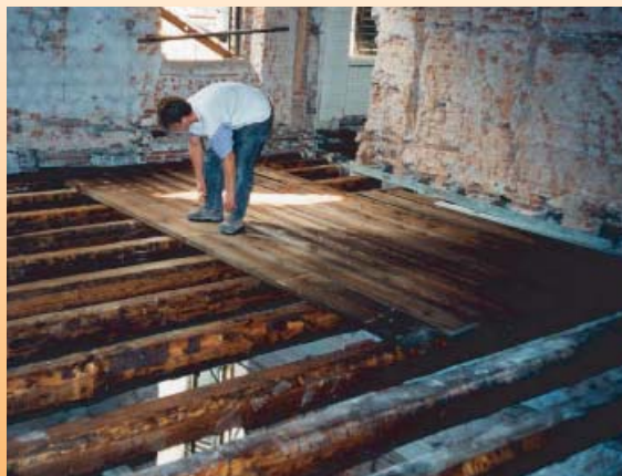
Después de la colocación de las nuevas vigas lignarias en los alojamientos ya existentes se ha extendido y clavado el entarimado sobrestante.
