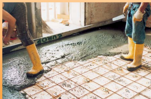
En la losa de hormigón se ha colocado siempre una malla electrosoldada del tamaño adecuado. En la foto: realización de la colada. Los forjados se han apuntalado.
