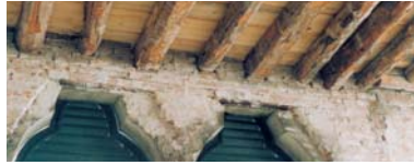
Vista desde abajo de un forjado que se debe reforzar. El buen estado de conservación de las vigas ha permitido efectuar la adecuación estática con esta técnica.
