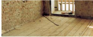
Vista de un forjado después de la eliminación del fondo y del pavimento ya existentes antes de la ejecución del refuerzo. A la derecha, vista del complejo de Campo Manin.
