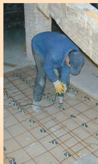
Fijación de los tornillos de los conectores mediante atornillador eléctrico de impulsos, con inserto hexagonal de 13 mm.
