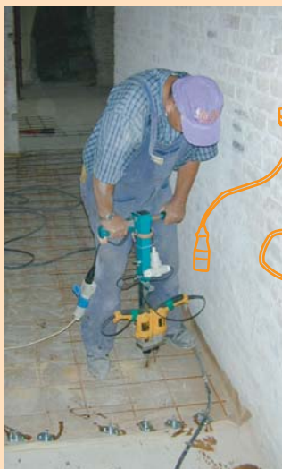
Preagujereado del entarimado y de la viga mediante taladro doble. Es posible incluso alquilar la herramienta
